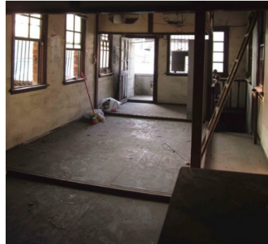
內部空間現況
