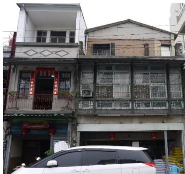
老屋立面外觀現況
